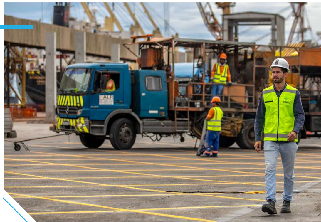
Obra de pintura e sinalização na faixa primária de cais
