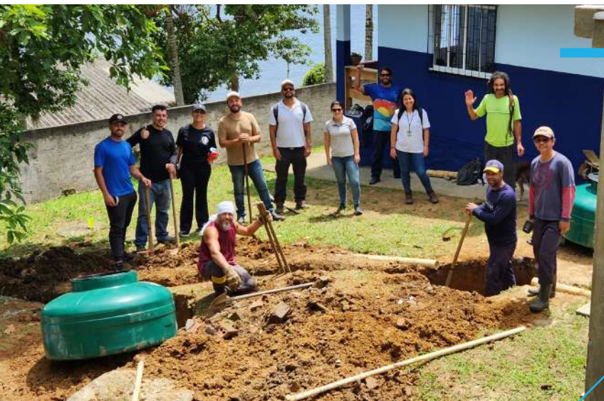
Mutirão para instalação de sistema ecológico de tratamento de efluentes em Eufrasina
