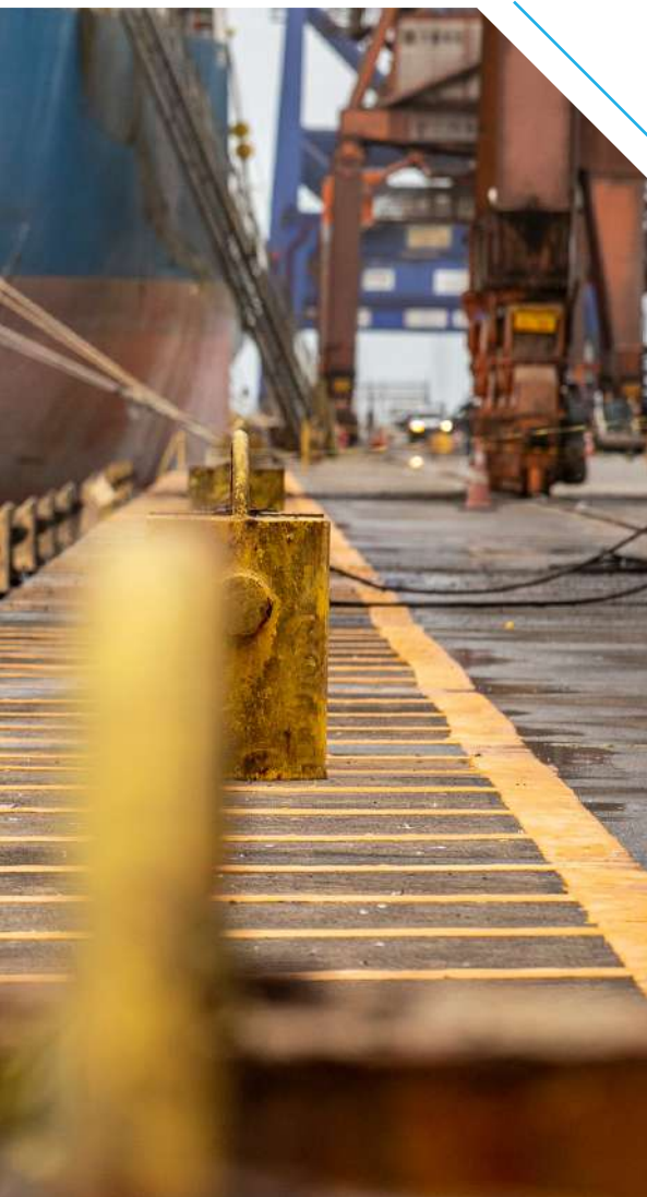
Linha de cais em Paranaguá com cabeços de amarração em primeiro plano
