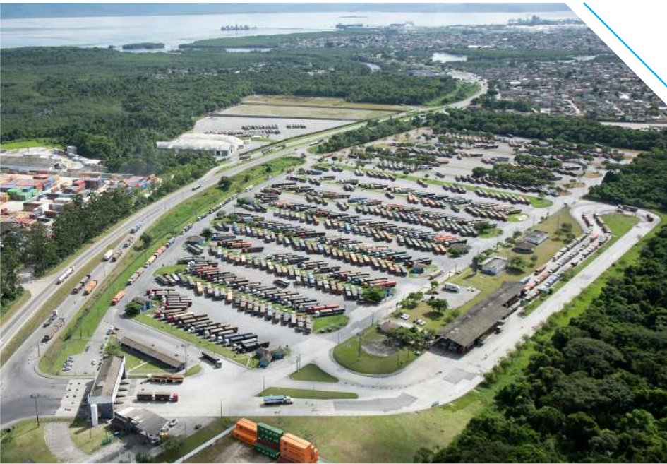
Vista aérea do Pátio de Triagem com a Baía de Paranaguá ao fundo
