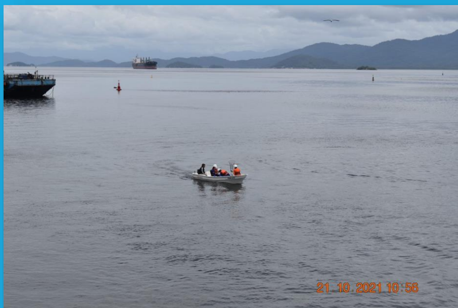
Andamento da etapa de varredura pós desmonte
