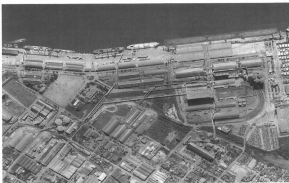
Complexo do Corredor de Exportação e Armazéns interligados:
